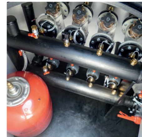
Übergeordneter Haupt-Verteilerschacht
