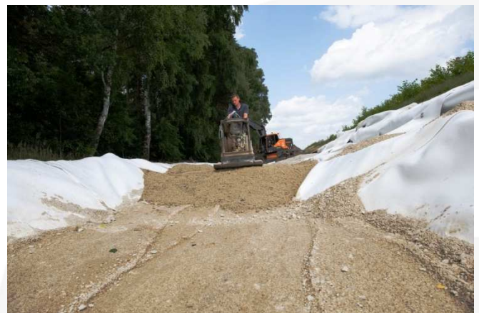
Verdichten mit der Rüttelplatte
