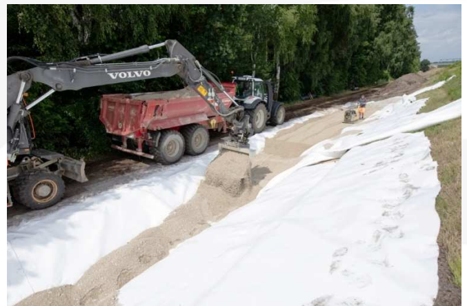
Befüllung mit mineralischem Schüttgut
