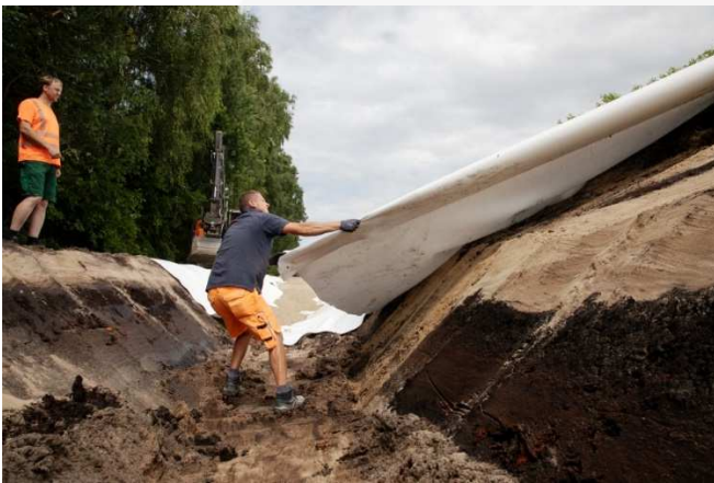
Einbau FRABRI 800 N BAW
