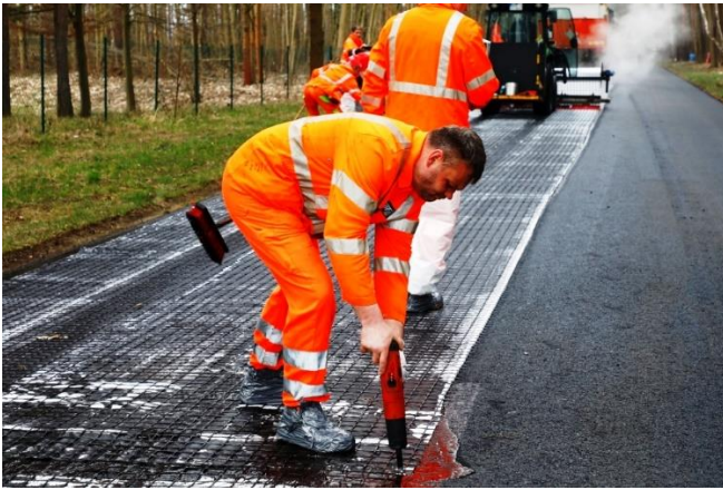
Baustellenansicht: Die Asphaltarmierung wird mit Stahlbolzen fixiert
