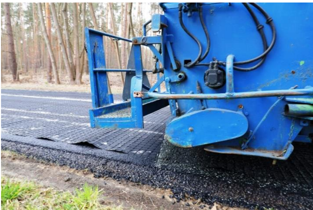
Baustellenansicht: Abstreuen mit Splitt
