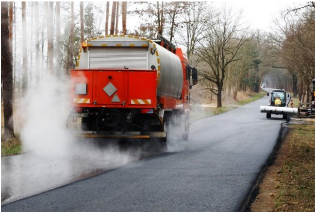
Baustellenansicht: Rampenspritzgerät im Einsatz
