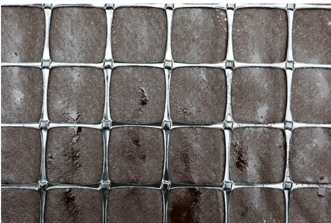
Baustellenansicht: Asphaltarmierungsgitter vollständig mit Bitumenemulsion getränkt
