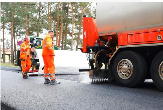
Baustellenansicht: Aufbringen der Bitumenemulsion mit einem Rampenspritzgerät und direkt danach Einbau der Asphaltarmierung
