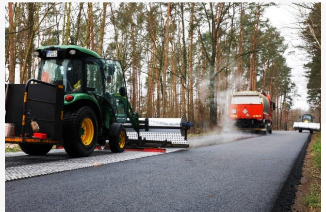
Baustellenansicht: Einbau Asphaltarmierungsgitter mit einer Verlegevorrichtung
