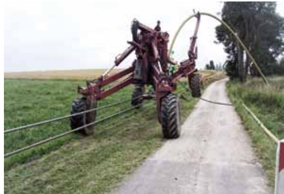
Abb. 24 – Neuverlegung (Pflügen): Verlegevorgang
