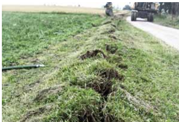
Abb. 25 – Neuverlegung (Pflügen): Geringe Flurschäden
