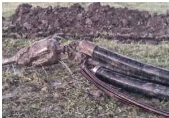
Abb. 29 – Neuverlegung (Horizontalspülbohren): Aufweitkopf mit drei Rohrsträngen
