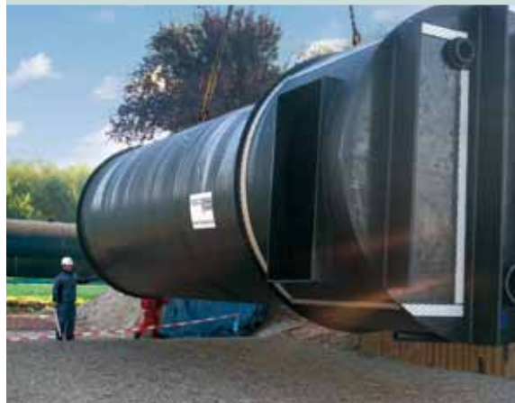
Abb. 2 – Einsetzen eines FTW®-Trinkwasserspeichers
