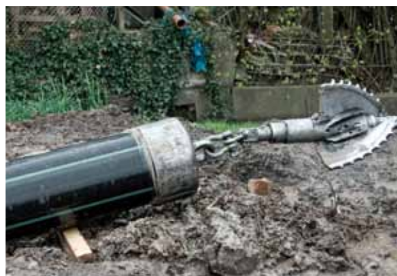
Abb. 30 – Neuverlegung (Horizontalspülbohren): Auch für Großrohre geeignet
