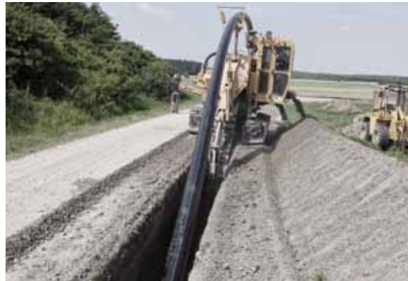
Abb. 27 – Neuverlegung (Fräsen): Verlegevorgang
