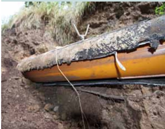
Abb. 1 – Verlegung einer Sureline-Rohrleitung mittels Berstlining
