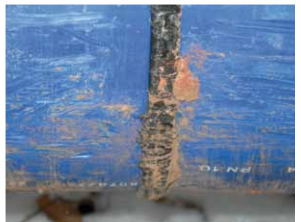
Abb. 32 – Neuverlegung (Berstlining): Höchste Anforderungen an das Neurohr
