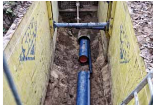
Abb. 22 – Erneuerung (Relining): mit Ringraum
