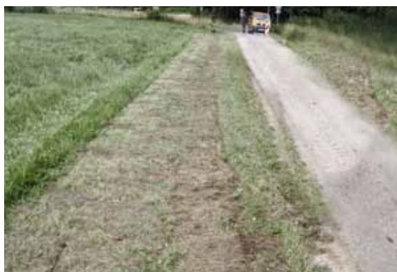
Abb. 26 – Neuverlegung (Pflügen): Grabenabsperungen in der Regel nicht notwendig
