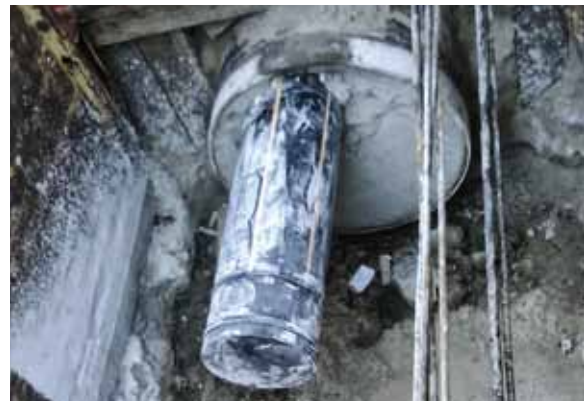
Abb. 23 – Erneuerung (Relining): mit Ringraum und anschließender Verfüllung
