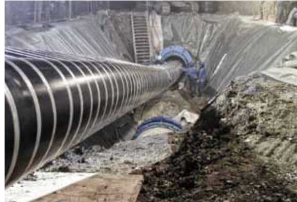
Abb. 21 – Sanierung (Relining): ohne Ringraum (close-fit-lining)
