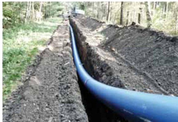
Abb. 28 – Neuverlegung (Fräsen): schmale Rohrtrassen
