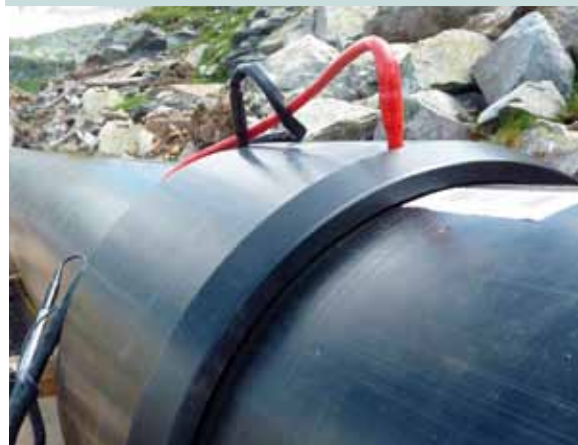
Abb. 4 – Heizwendelschweißung
