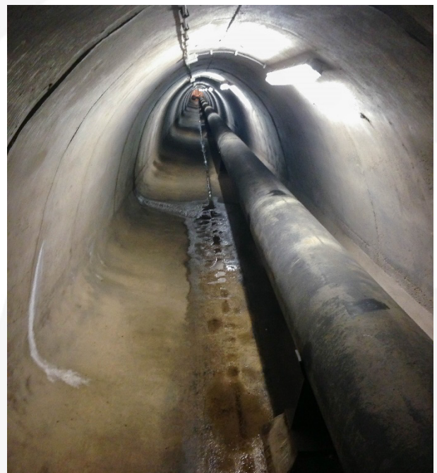
Alte Stahlrohrleitung DN 500 im Stollen
