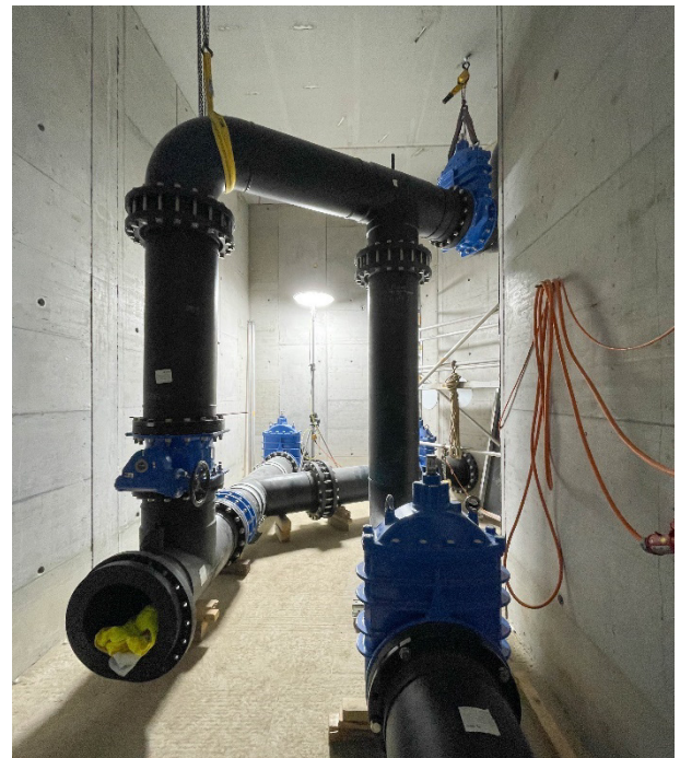
Einlaufbauwerk vom Stollen auf Maß gefertigte PE-Sonderlösungen im Einlaufbauwerk in Richtung Stollen
