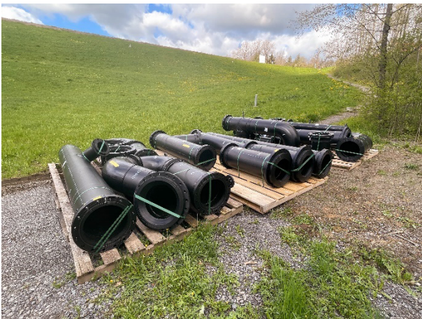
Speziell vorgefertigte da 450 mm Rohrstränge und Sonderbauteile
