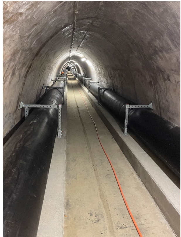
Verbaute FRANK Abflussrohrleitung aus PE 100-RC im Stollen
