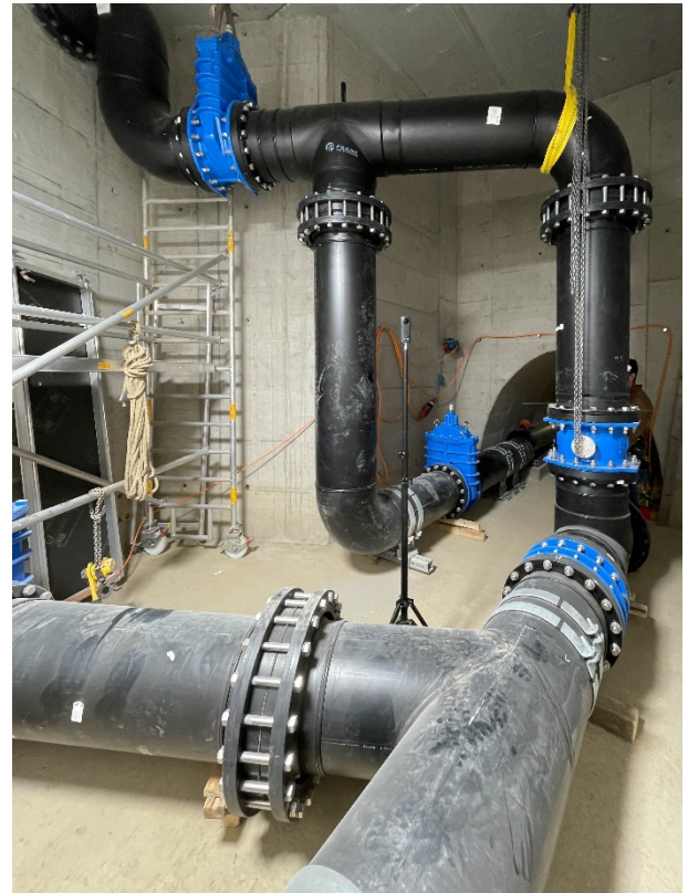
Auf Maß gefertigte PE-Sonderlösungen im Einlaufbauwerk in Richtung Stollen
