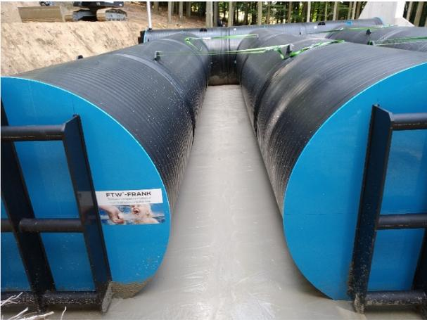
Bild 5: Einbau von Flüssigboden im Zwickelbereich
