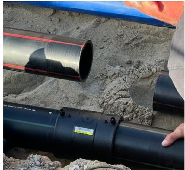
Abbildung 3: Schweißvorbereitung zur Verbindung der ThermLine Rohre d125 mm SDR17 und AGRU Heizwendelmuffe aus PE 100-RC
