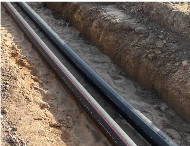
Abbildung 2: Anlieferung der ThermLine-Rohre da 125 mm SDR 17 mit roten und grünen Streifen
