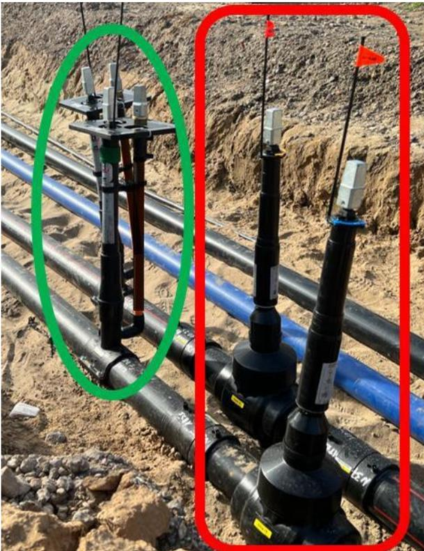
Abbildung 4: ThermLine-Leitungen d180 mm SDR 17
