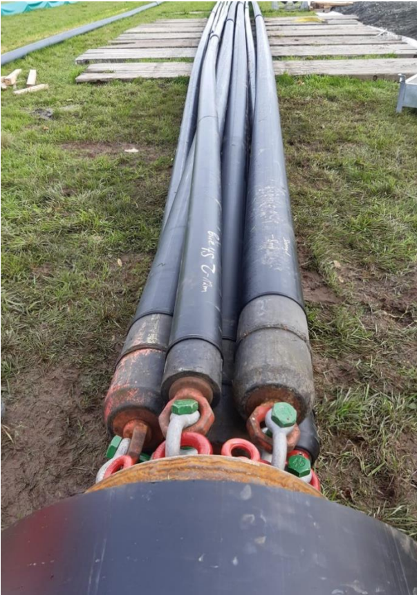
Abbildung 7: Einzugsvorgang von Kabelschutzrohrsträngen in die Schutzrohre
