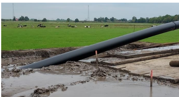
Abbildung 4: Einziehvorgang der geschweißten da 400 mm SDR 7,4 Rohrleitung an der Startgrube
