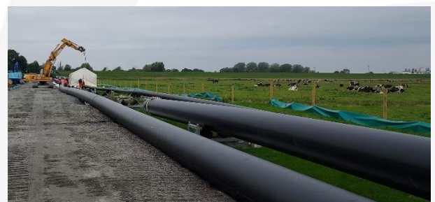
Abbildung 2: Schweißdurchführung der da 400 mm und da 710 mm Rohre vor dem Einziehvorgang
