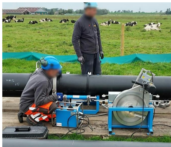
Abbildung 6: Schweißen der goldenen Schweißnaht durch Einsatz von Verbindungsstücken mit Anfasung
