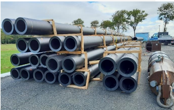
Abbildung 1: Links: Anlieferung der da 400 mm SDR 7,4 Rohrstangen - Rechts: Ziehkopf des HDD-Verfahrens
