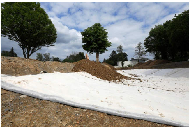
Baustellenansicht: die Überdeckung wird vorbereitet
