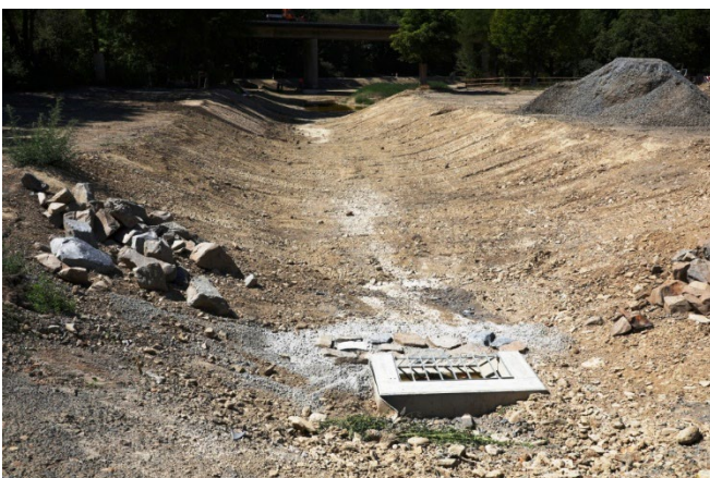
Baustellenansicht: Überdeckung eingebaut
