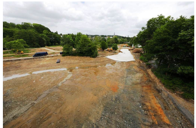
Baustellenansicht: Einbau der Bentonitmatten als Abdichtung
