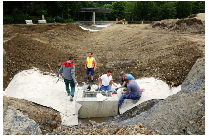
Baustellenansicht: Anbindung der Abdichtung an die Durchführung
