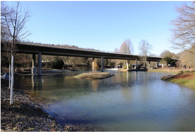
Baustellenansicht nach Fertigstellung
