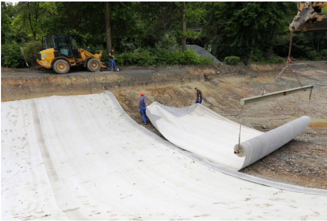
Baustellenansicht: Einbau der Bentonitmatten mit einer Verlegetraverse
