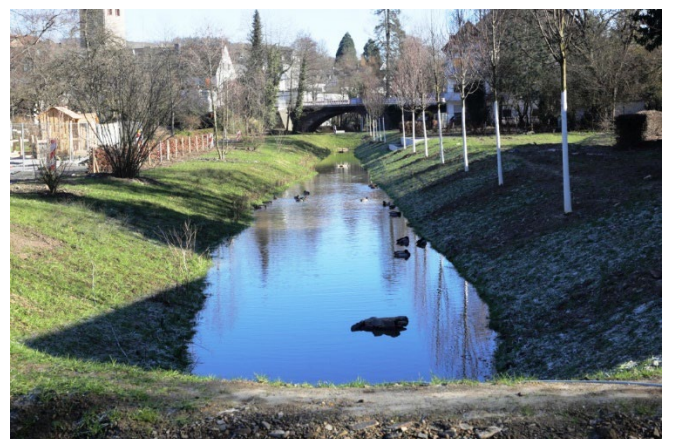
Baustellenansicht nach Fertigstellung
