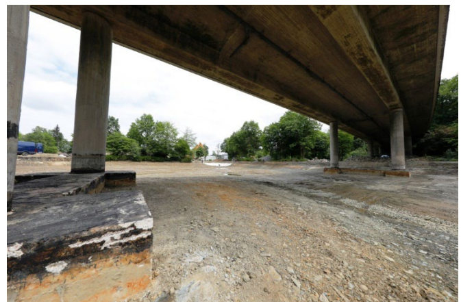
Baustellenansicht: die neugestaltete Wasserfläche erstreckt sich unter dem Brückenbauwerk der Umgehungsstraße
