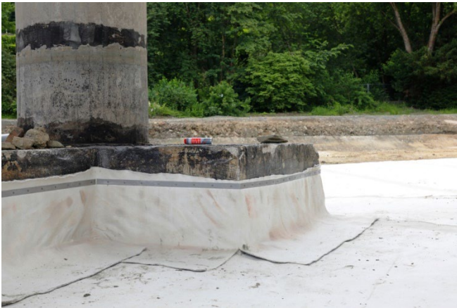
Baustellenansicht: Anbindung der Abdichtung am Brückenbauwerk
