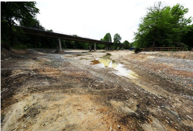
Baustellenansicht: die zukünftigen Wasserflächen sind für den Einbau der Abdichtung vorbereitet
