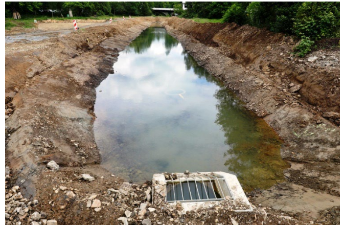
Baustellenansicht: Zulauf zu den Wasserflächen
