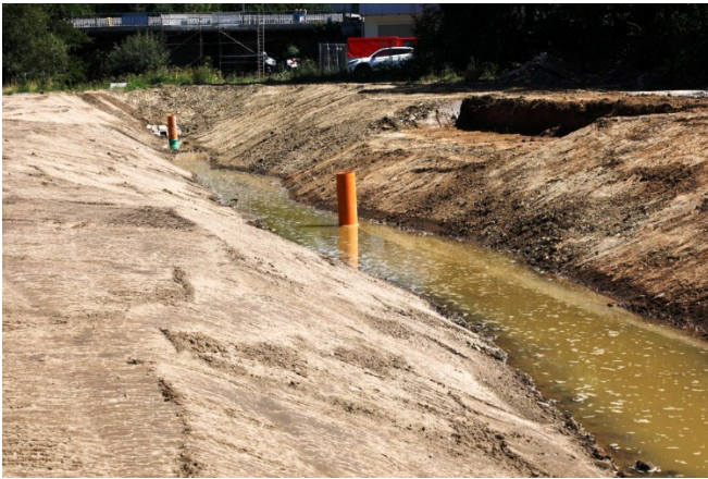
Baustellenansicht: Einbau von Rohren für den Grundwasserausgleich im Zulauf
