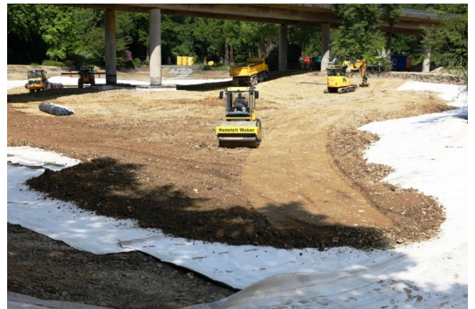
Baustellenansicht: Einbau der Überdeckung
