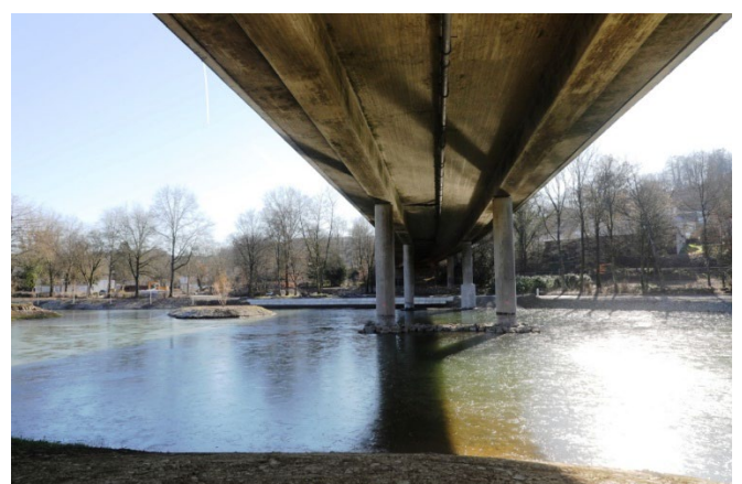
Baustellenansicht nach Fertigstellung
