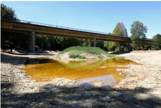
Baustellenansicht: Modellierung der zukünftigen Insel
