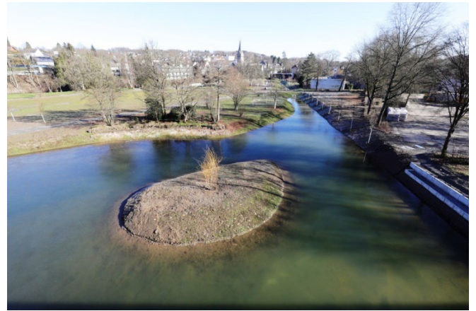
Baustellenansicht nach Fertigstellung: Blick vom Brückenbauwerk
