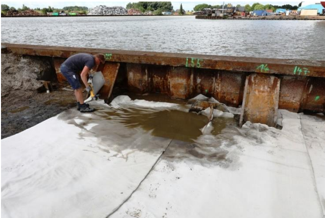
BVR kann auch bei direktem Wasserkontakt problemlos eingebaut werden
