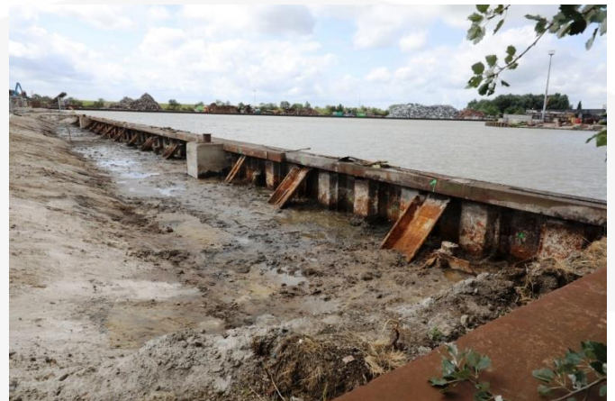
Abgetragenem Boden im Bereich der Spundbohlenuferbefestigung
