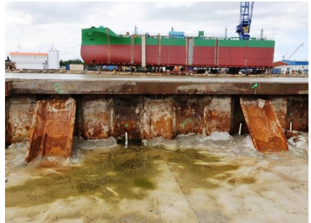
Baustellenansicht mit gegenüberliegender Werft
