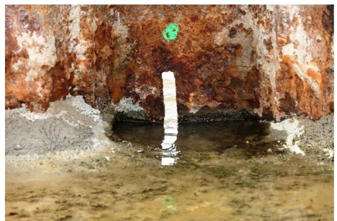
Schlitze in den Spundbohlen ermöglichen den Ablauf von Oberflächenwasser
