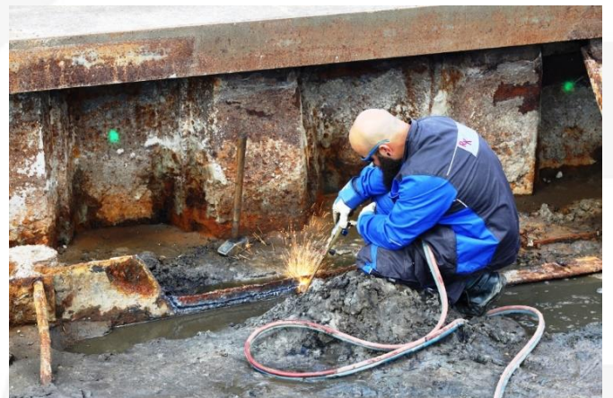
Alle störenden Stahlelemente werden entfernt
