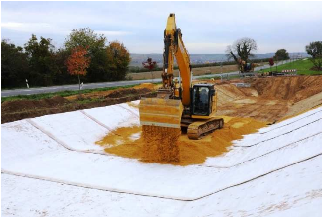
Die Tondichtungsbahn darf nicht direkt befahren werden. Die Sandüberdeckung wird daher vor Kopf eingebaut.
