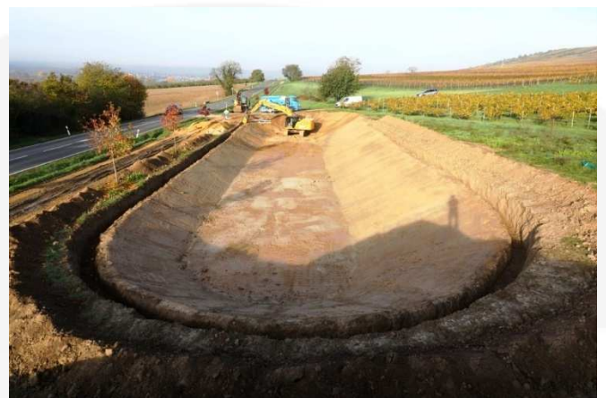
Das Erdbecken vor Einbau der Tondichtungsbahn FRANK Eurobent 3700
