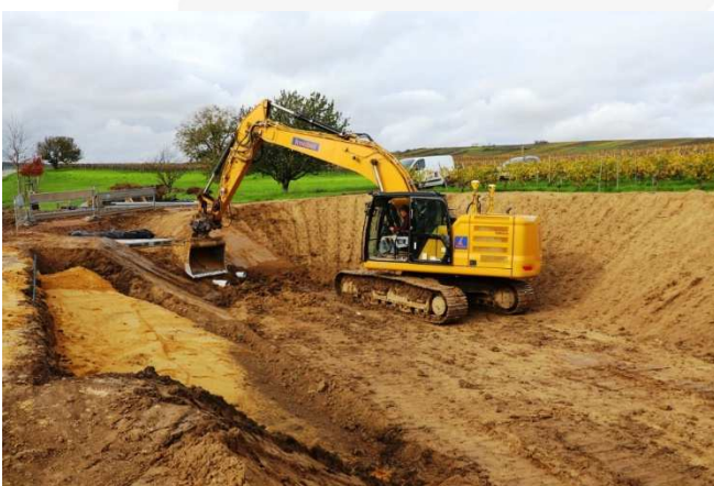
Die Überdeckung der Bentonitmatte ist vollständig eingebaut
