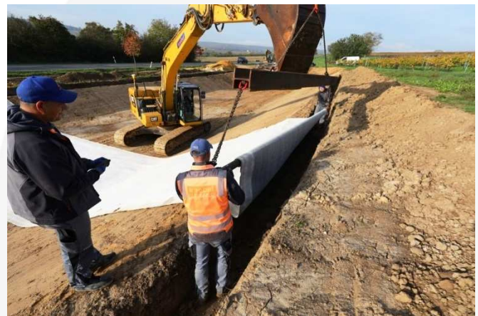
Verlegen der Tondichtungsbahn in den Einbindegraben
