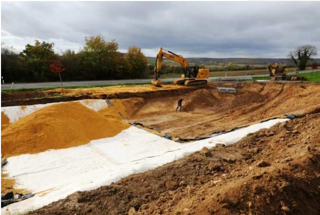
Baustellenansicht - Übersichtsbild in der Bauphase
