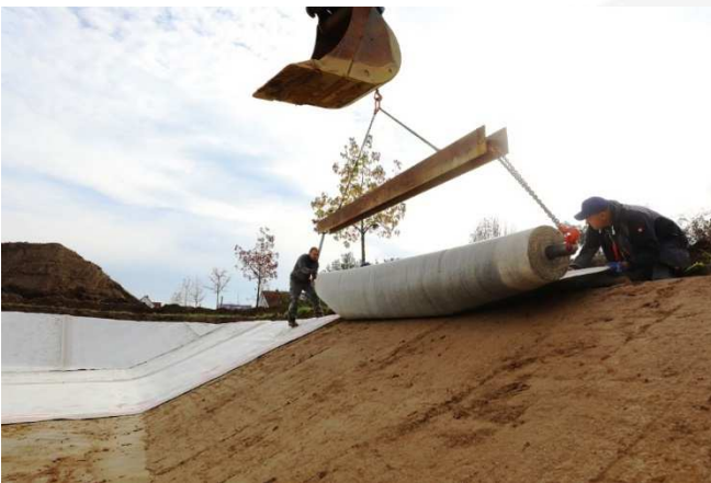
Einbau mittels Verlegetraverse
