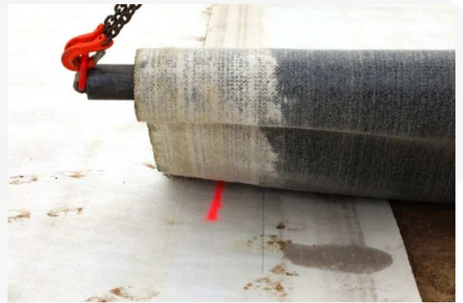
Detailansicht Verlegung mit Traverse
