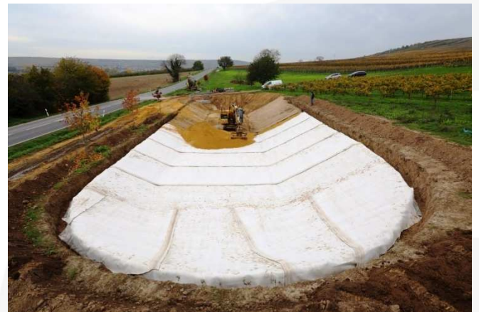
Aufbringen der Überdeckung
