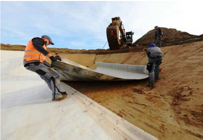
Positionieren der Tondichtungsbahn
