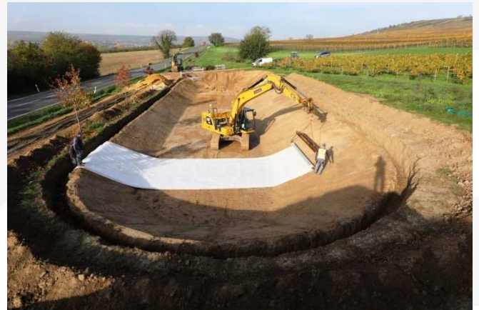
Einbau der Tondichtungsbahn
