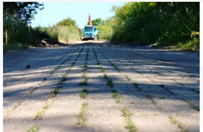
Baustellenansicht: Baustelle mit dem vorhandenen Straßenoberbau
