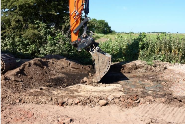
Sondierung und Freilegung im kontaminierten Bodenbereich
