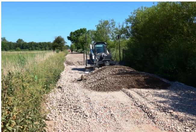
Einbau der Schottertragschicht
