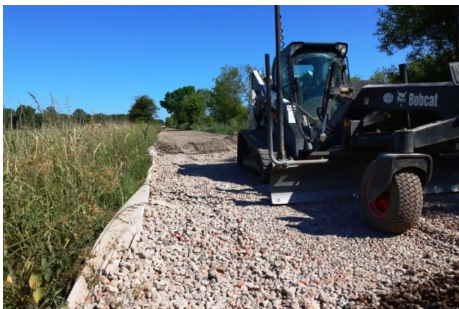
Einbau der Schottertragschicht
