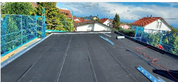
Die Dachneigung beträgt 7°.
