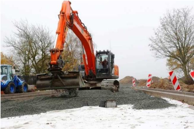
Baustellenansicht: Einbau Schottertragschicht oberhalb des FGV-T 30/30 (im Bild als weiße Fläche)
