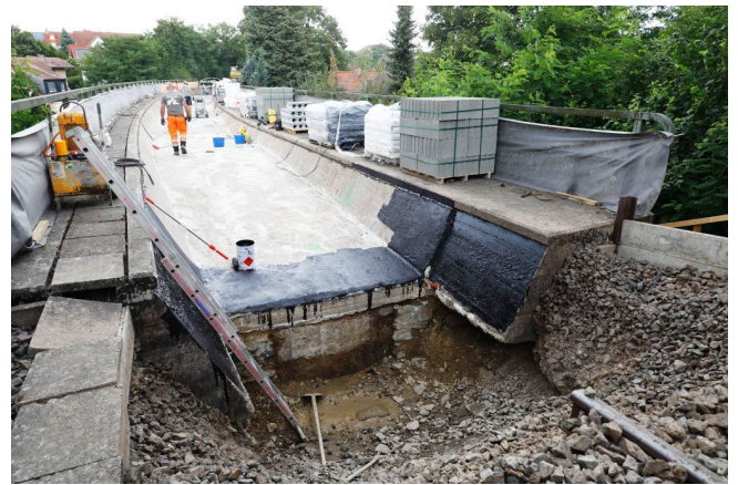
Grundierung auftragen
