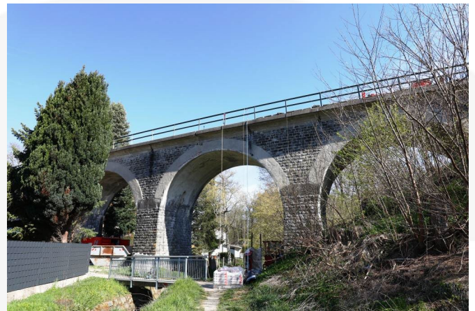
Viadukt Neu Anspach
