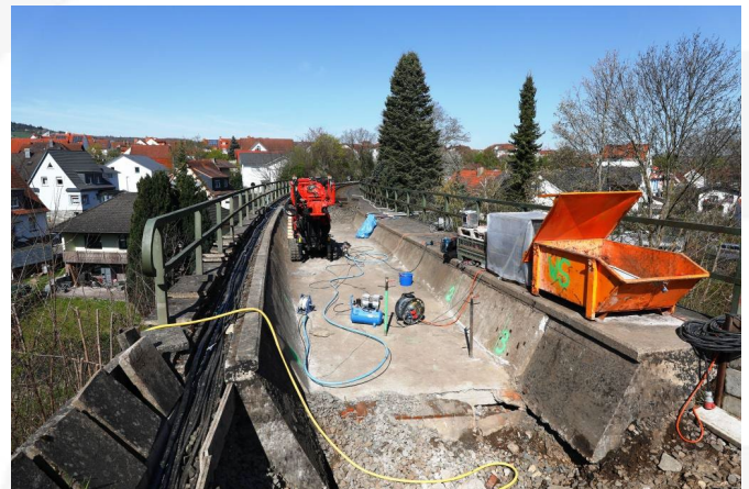
Gleisbett ausgebaut und Sanierung vorbereitet
