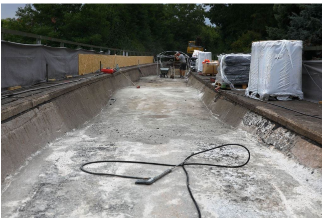
Zur Sanierung vorbereitete Fläche
