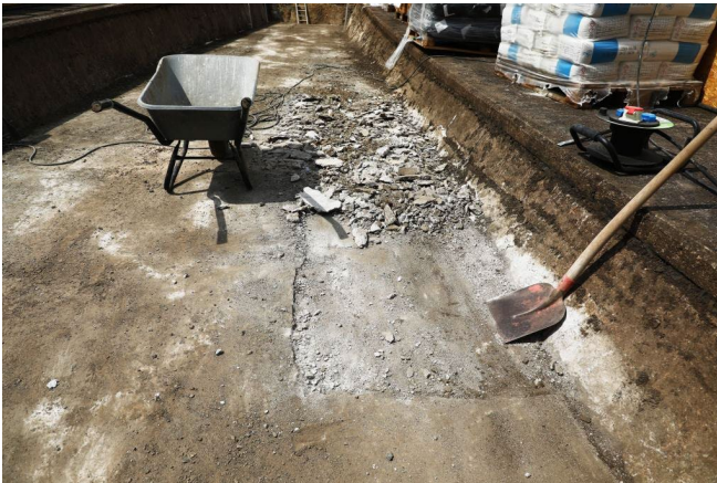
Ausbau der defekten Mörtellage
