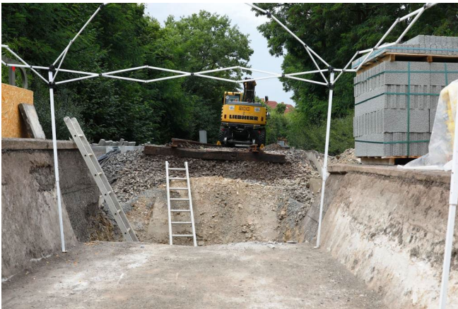
Materialtransport mit einem 2-Wege-Bagger
