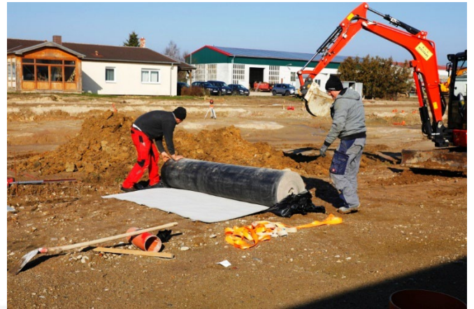
Baustellenansicht: Vorbereitung der BVR 9000 HP plus 0,5 zum Einbau
