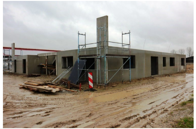
Baustellenansicht: das neue Betriebsgebäude im Rohbau
