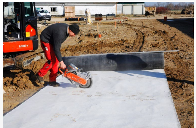
Baustellenansicht: Vorbereitung für den Einbau - Zuschnitte ablängen
