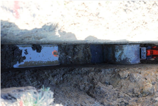
Baustellenansicht: Herstellung der Gräben für die Schlitzwand mit BVR
