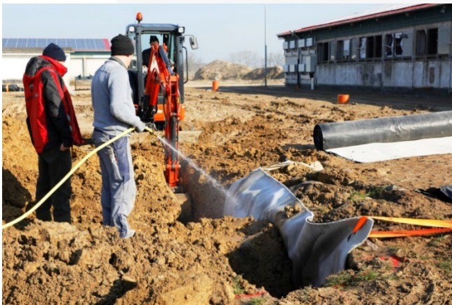
Baustellenansicht: BVR aktivieren
