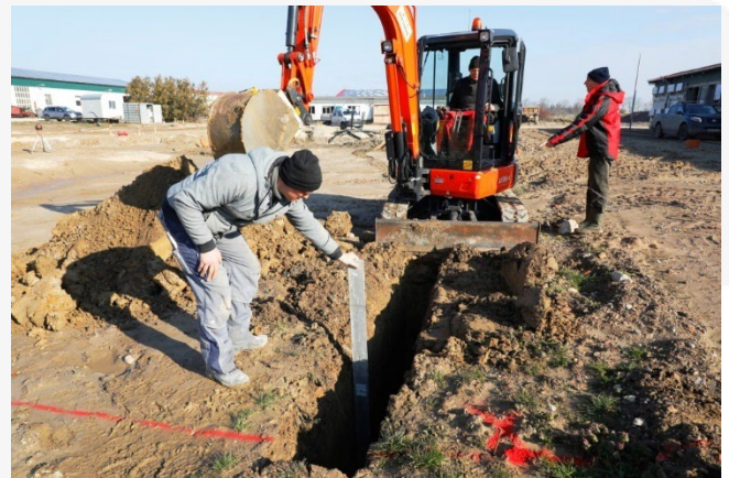
Baustellenansicht: Grabentiefe ca. 2,30 -2,35 m
