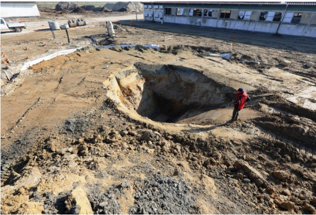
Baustellenansicht: Grube erstellt
