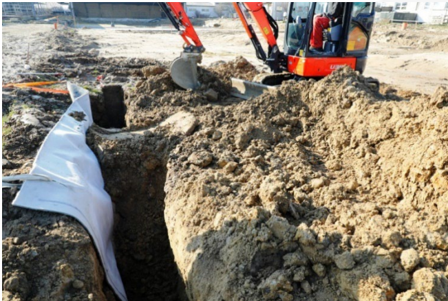
Baustellenansicht: Graben verfüllen
