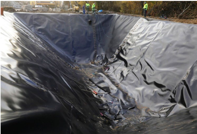
Baustellenansicht: Kunststoffdichtungsbahnen verlegt und geschweißt
