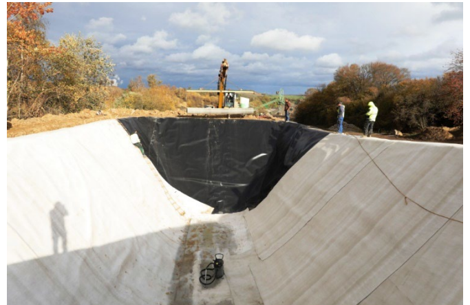
Baustellenansicht: Einbau 1. Schutzlage BVR
