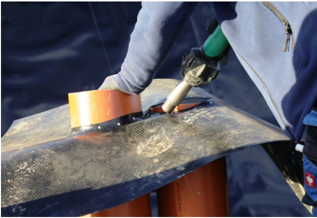
Baustellenansicht: Abdichtung Rohrdurchführungen
