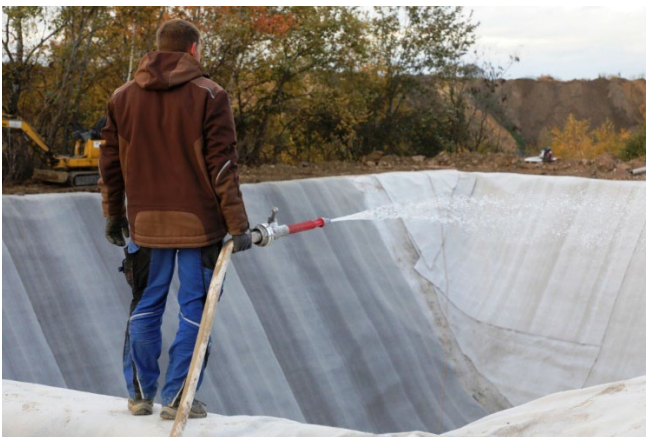
Baustellenansicht: wässern / aktivieren der BVR-Bahnen
