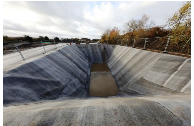
Baustellenansicht nach Fertigstellung
