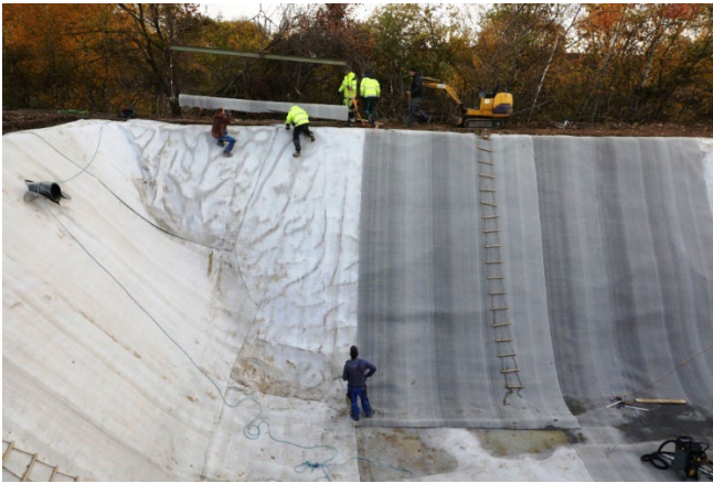
Baustellenansicht: 2. Lage BVR mit der Gewebeseite nach oben
