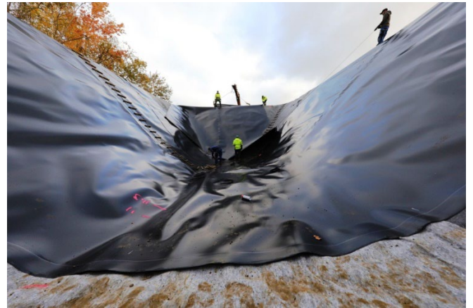
Baustellenansicht: Einbau der Kunststoffdichtungsbahnen
