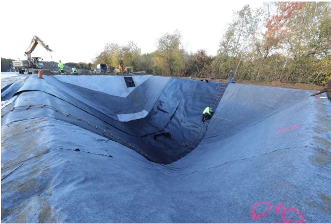
Baustellenansicht: Einbau der Kunststoffdichtungsbahnen
