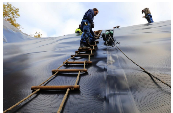
Baustellenansicht: Schweißen der Kunststoffdichtungsbahnen
