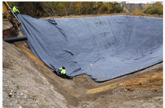
Baustellenansicht: Schutzvlies einbauen
