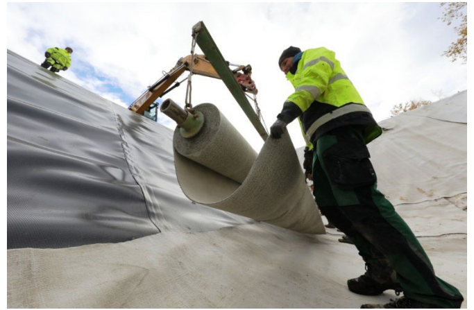
Baustellenansicht: Einbau 1. Schutzlage BVR
