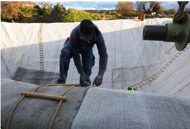
Baustellenansicht: Schweißen der BVR-Bahnen im Überlappungsbereich
