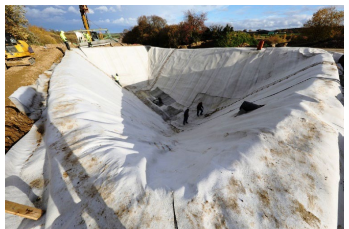
Baustellenansicht: 1. Lage BVR eingebaut
