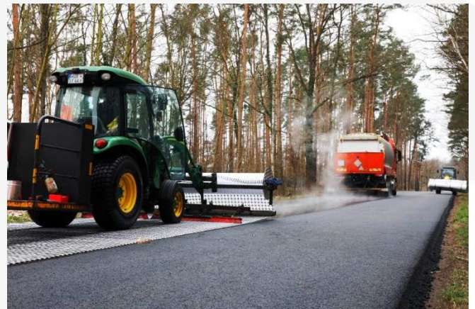
Baustellenansicht: Einbau Asphaltarmierungsgitter mit einer Verlegevorrichtung
