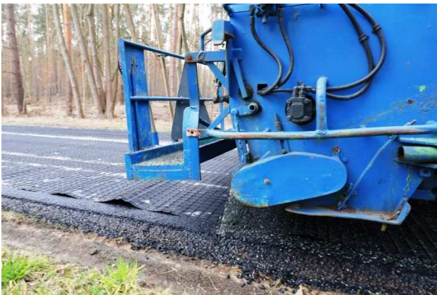
Baustellenansicht: Abstreuen mit Splitt
