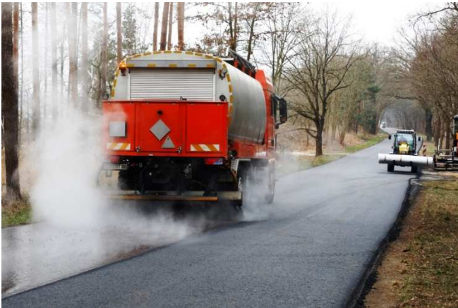
Baustellenansicht: Rampenspritzgerät im Einsatz
