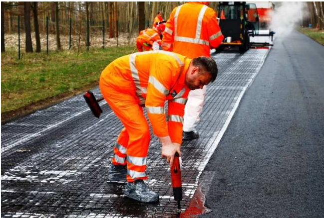
Baustellenansicht: Die Asphaltarmierung wird mit Stahlbolzen fixiert
