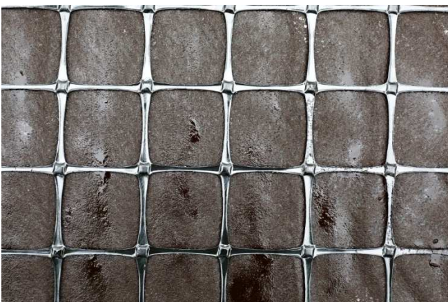
Baustellenansicht: Asphaltarmierungsgitter vollständig mit Bitumenemulsion getränkt
