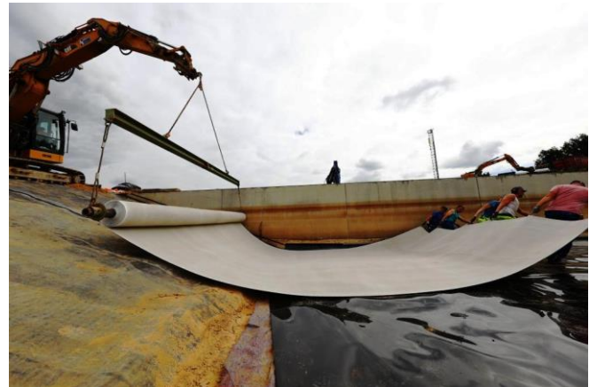
Baustellenansicht: Einbau BVR 9000 HP
