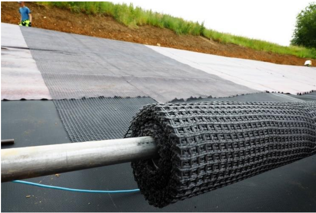
Baustellenansicht: Einbau Geogitter auf der Böschung
