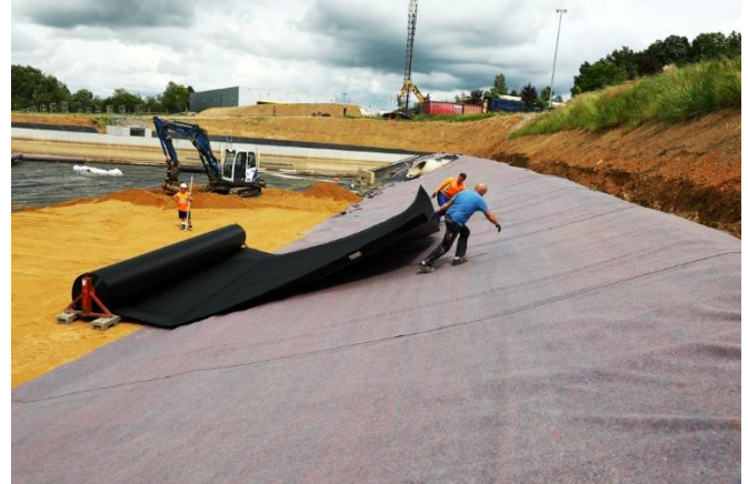
Baustellenansicht: Einbau der strukturierten KDB auf der Böschung
