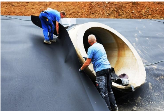
Baustellenansicht: Einbindung an die Bauwerke / Durchführungen
