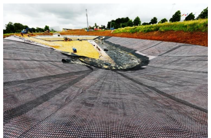
Baustellenansicht: Einbau Geogitter auf der Böschung
