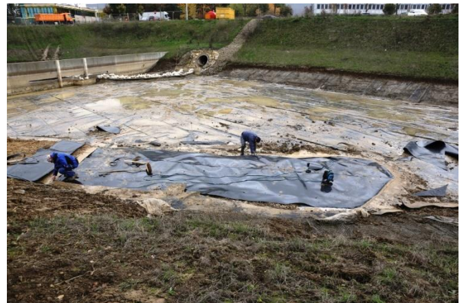
Baustellenansicht: temporäre Reparaturmaßnahme 2020
