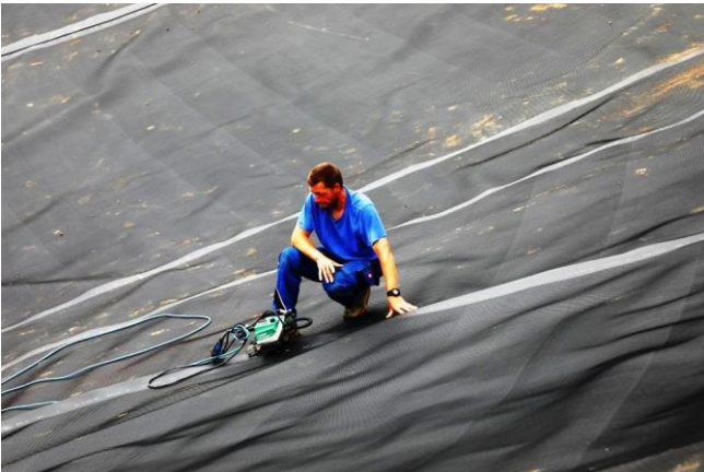
Baustellenansicht: KDB-Bahnen schweißen
