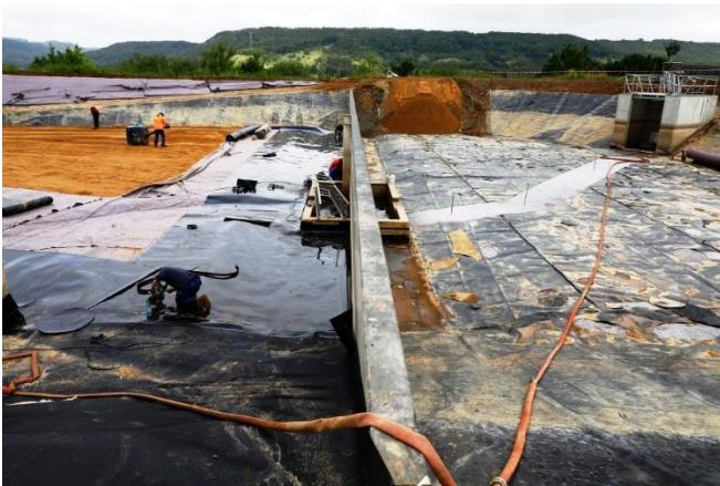
Baustellenansicht: Einbau Geogitter auf der Böschung
