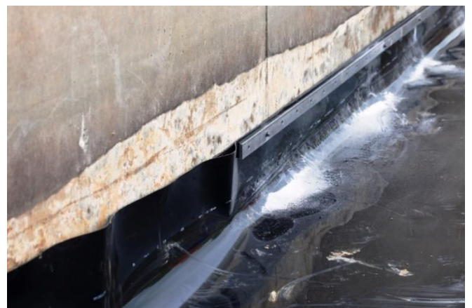
Baustellenansicht: Einbindung an die Bauwerke / Durchführungen
