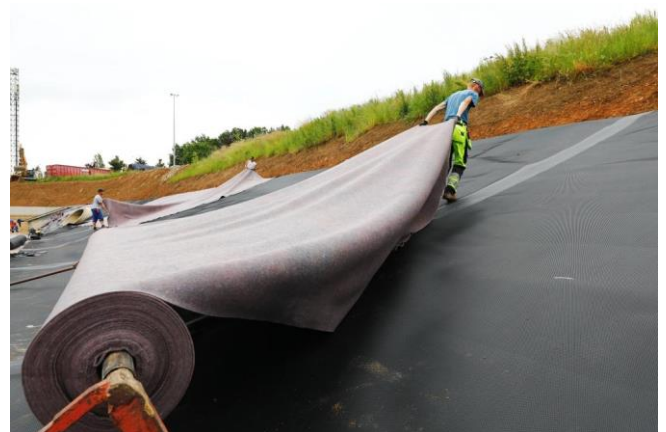
Baustellenansicht: Einbau des Schutzvlieses auf die „neue“ KDB
