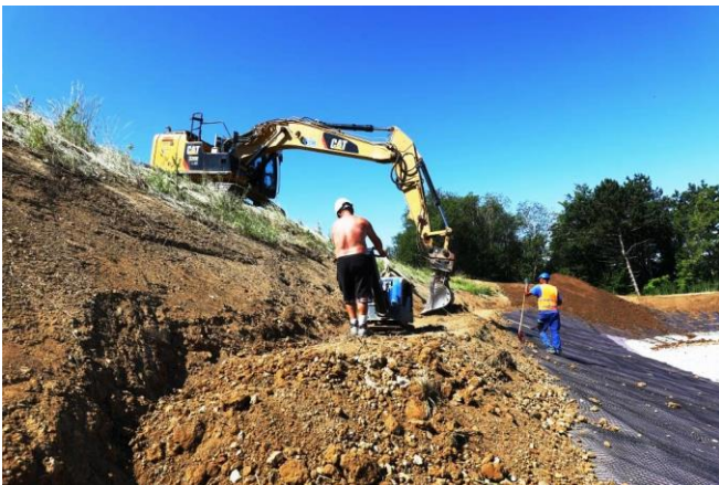
Baustellenansicht: Einbindegraben verfüllen
