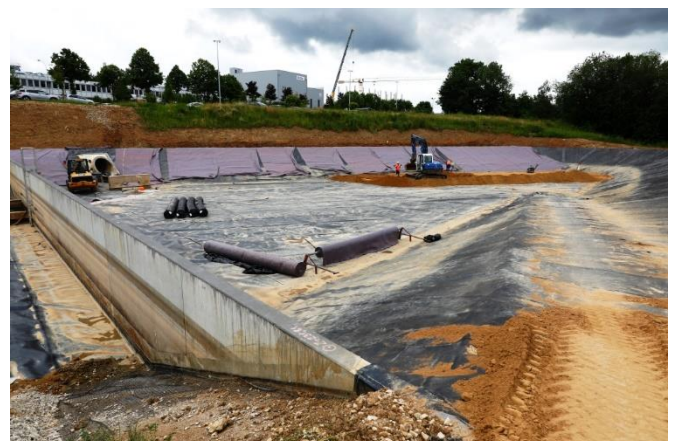
Baustellenansicht: Start der Sanierungsmaßnahme 2022
