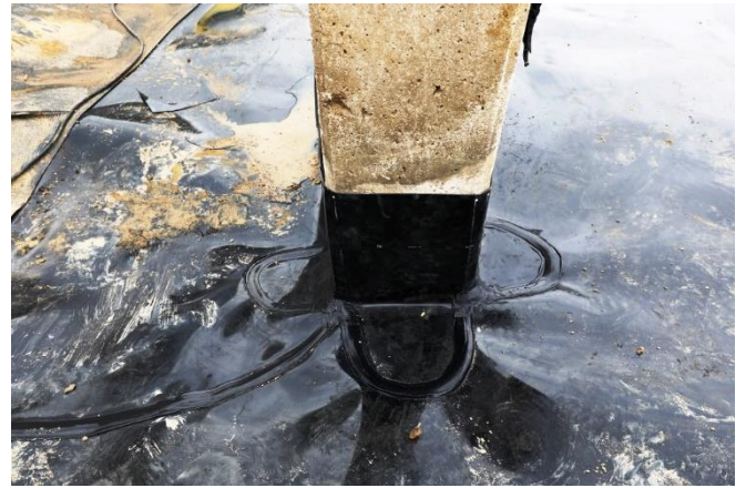
Baustellenansicht: Einbindung an die Bauwerke / Durchführungen
