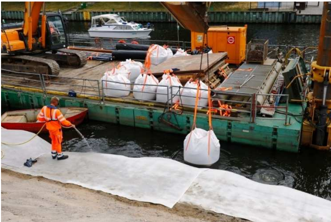
Baustellenansicht: aktivieren und mit Bigbags sichern
