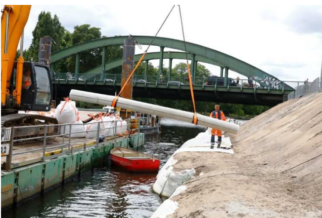
Baustellenansicht: Bereitstellung und Positionierung der Rolle
