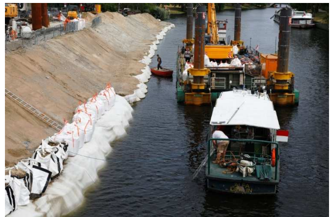
Baustellenansicht: durch eine hohe Verlegeleistung ist ein schneller Baufortschritt möglich
