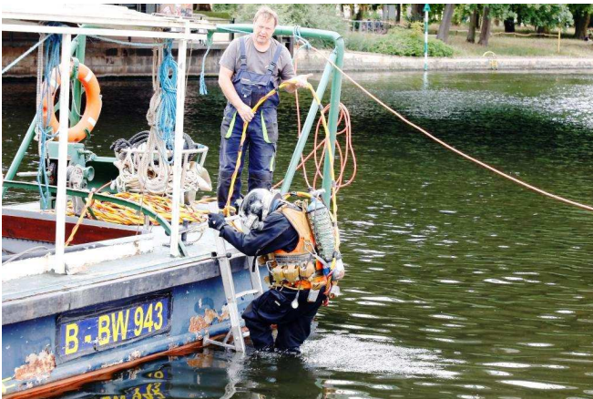
Baustellenansicht: die Unterwasserposition der BVR-Rollen wird durch einen Taucher überwacht
