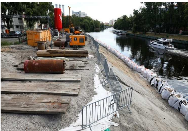
Baustellenansicht: Arbeitsplattform für ein Bohrgerät
