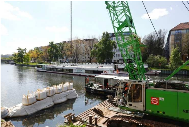
Baustellenansicht: Bauabschnitt Versuchsaufbau
