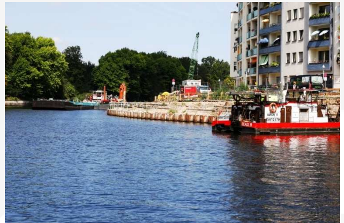
Baustellenansicht: konventioneller Spundbohlenverbau
