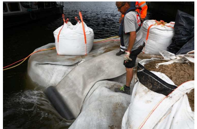
Baustellenansicht: Einbau von „kleinen“ Rollen und Sicherung durch Bigbags
