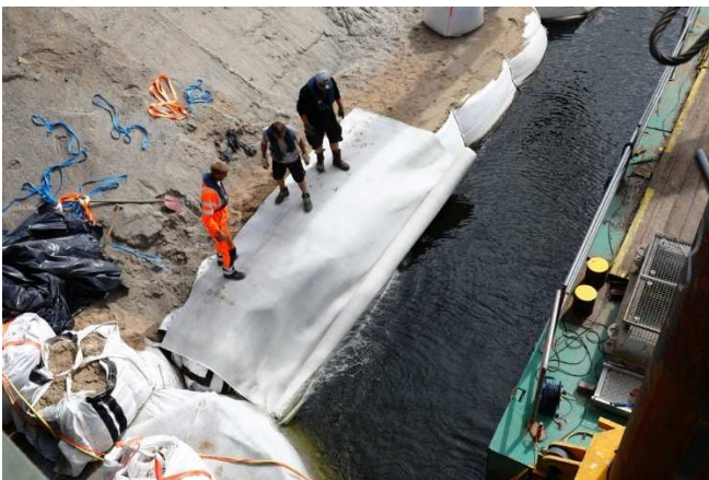
Baustellenansicht: unkomplizierter Einbau
