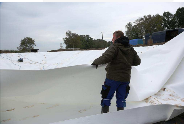
Baustellenansicht: die Verlegung der TPD ist auf Grund des geringen Flächengewichtes von Hand möglich
