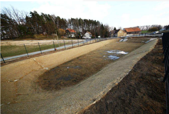
Baustellenansicht nach Fertigstellung
