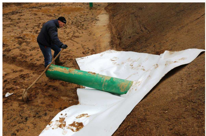
Baustellenansicht: der Einbau erfolgte zuerst im Bereich der Rohrdurchführungen
