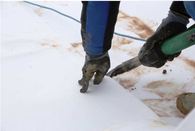
Baustellenansicht: Verschweißen der Überlappungen mit Heißluft
