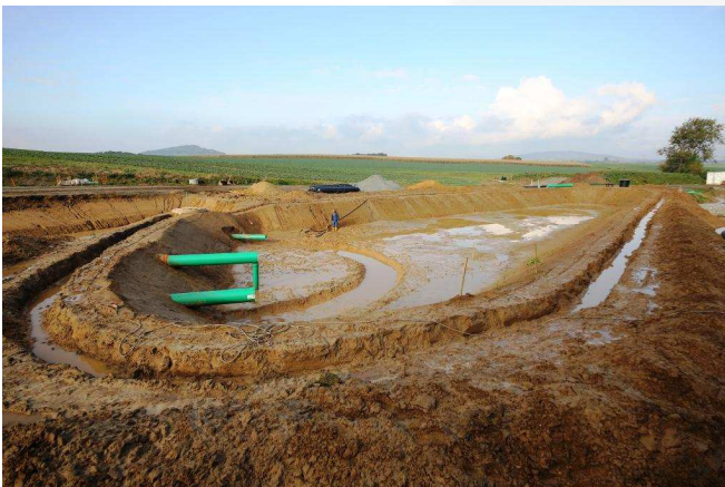
Baustellenansicht am Tag des Einbaus
