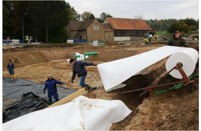
Baustellenansicht: zum Einbau der TPD ist eine Verlegetraverse nicht notwendig
