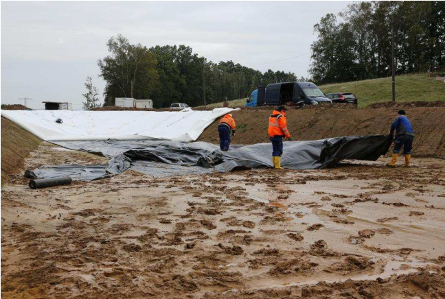
Baustellenansicht: provisorische Folienunterlage
