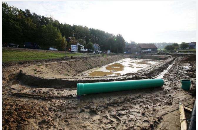
Baustellenansicht am Tag des Einbaus
