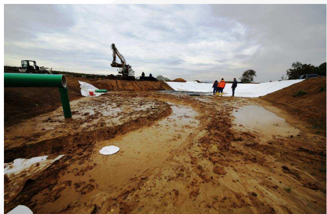
Baustellenansicht: extrem schwierige Einbaubedingungen
