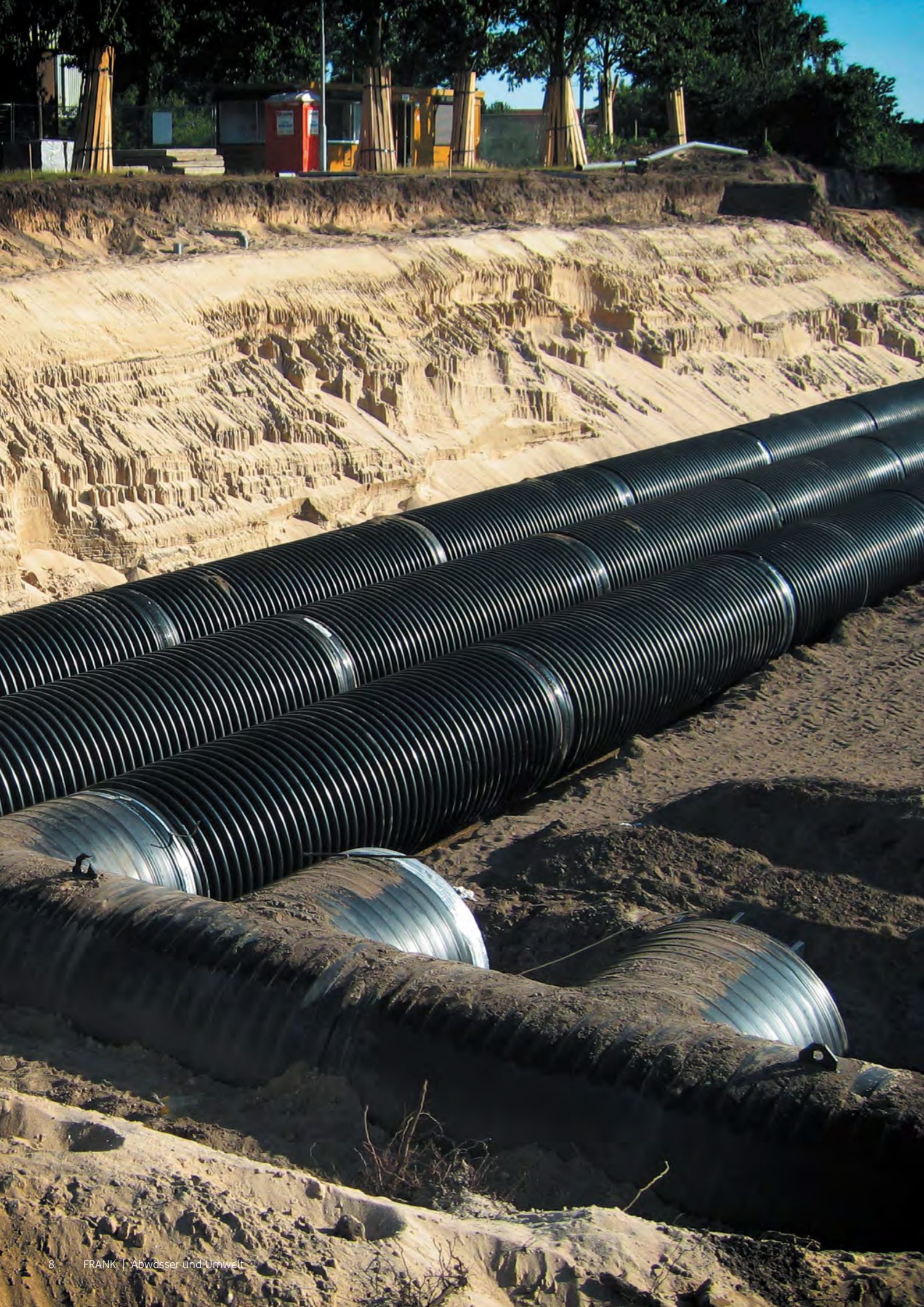
Behälter als Rohrstrang mit Revisionsschacht und zwei Enddeckeln
