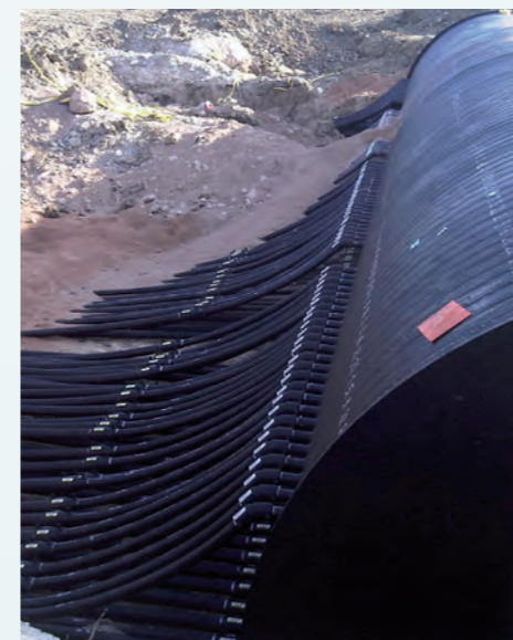
Anbindeleitung am Verteilerschacht in horizontaler Bauweise
